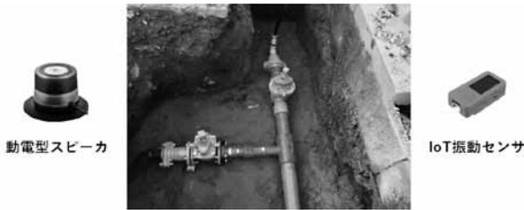
図2 埋設水道管のアクティブセンシング
