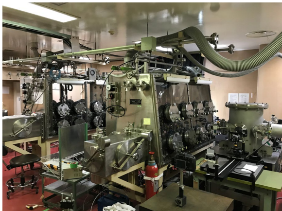
日本最大のトリチウム利用設備
