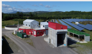
興部北興バイオガスプラント
