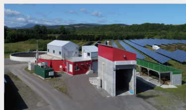
興部北興バイオガスプラント
